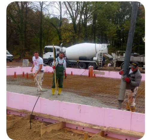
Das Grundstück im Oktober 2013
